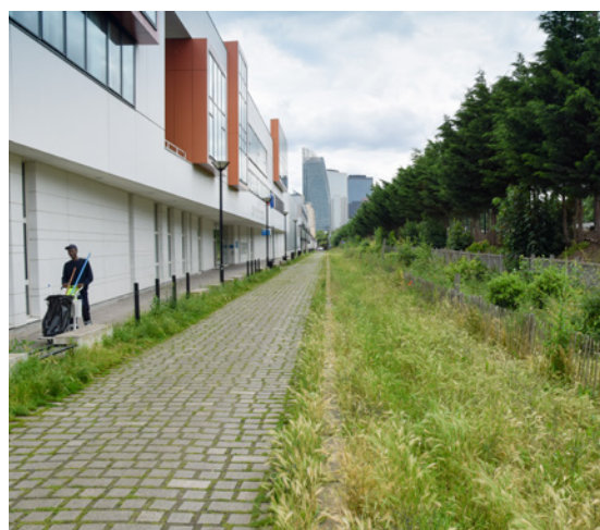
À Courbevoie (92), la noue de l'avenue du Château du Loire limite le ruissellement. © Gilles Lecuir
