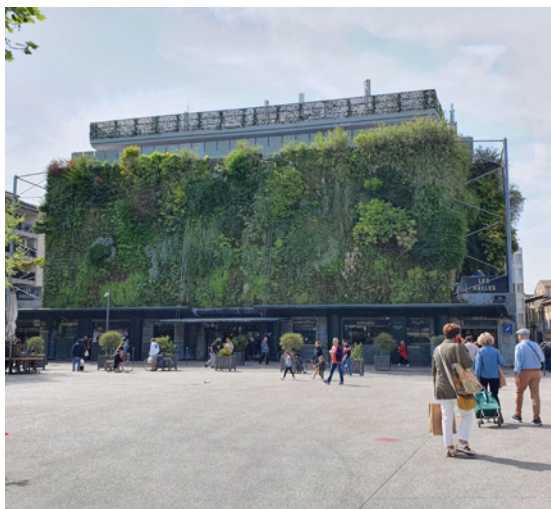
Illustration de la maladaptation : une végétalisation de bâti avec des modules hors-sol, consommateurs de ressources à la fabrication et accueillant des espèces non-locales gourmandes en eau. © Gabrielle Huart
