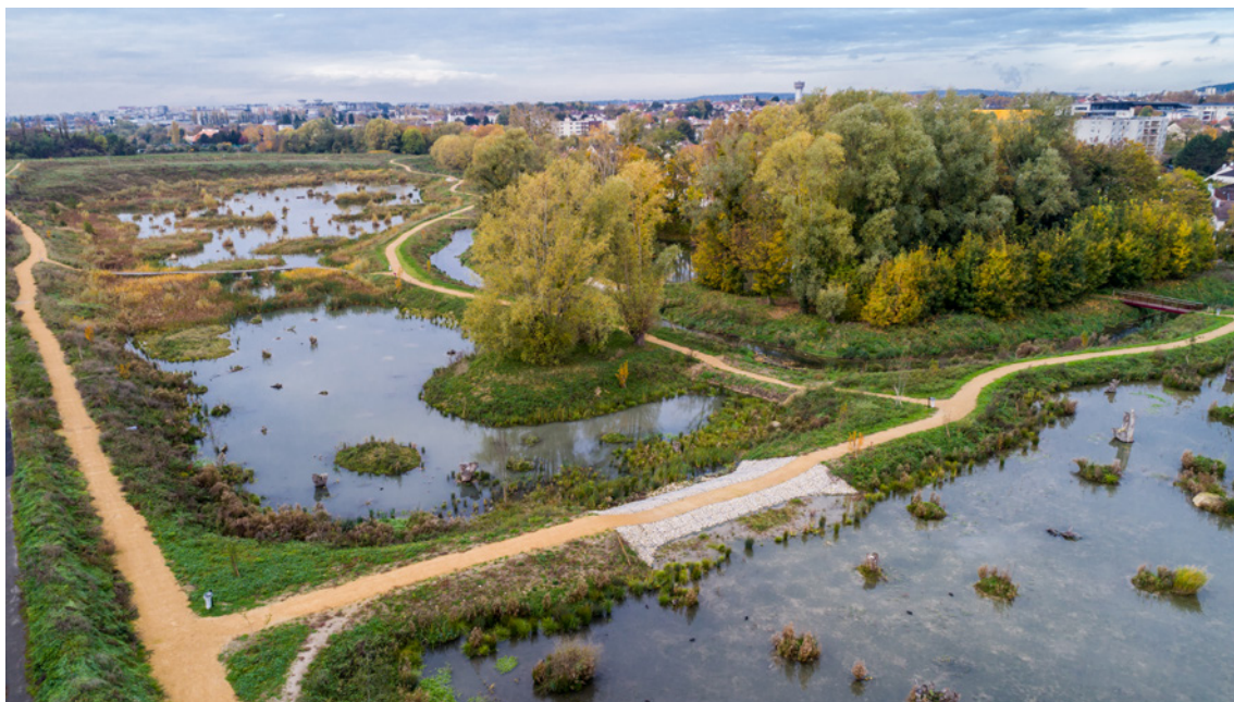
La zone d'expansion des crues du Vignois à Gonesse. © SIAH
