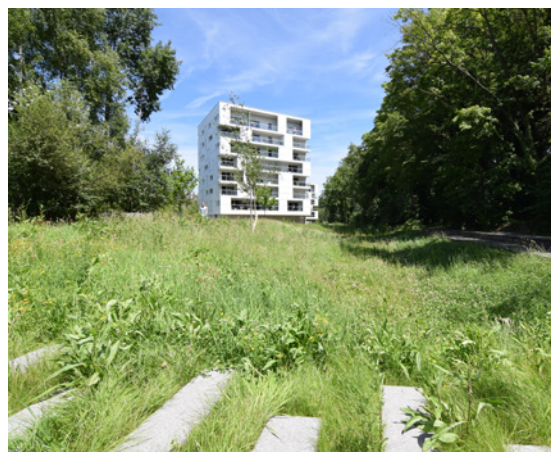
À la Courrouze, les ouvrages de gestion intégrée des eaux pluviales ont été conçus en s'appuyant sur les milieux naturels de l'ancienne friche. © Gilles Lecuir
