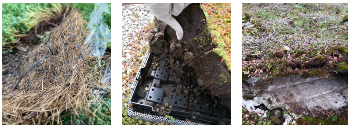
Exemples de composants artificiels utilisés pour concevoir certaines toitures végétalisées : filets, membranes et bacs plastiques, caissettes métalliques ou encore polyester. De gauche à droite, © Gwendoline Grandin, Marc Barra, Marc Barra
