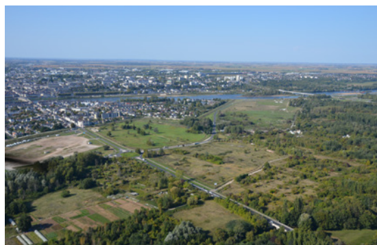
Le site de Bouillie est progressivement renaturé : les bâtiments sont démolis et les espaces artificialisés sont réaménagés afin de restaurer une zone d'expansion des crues. © AGGLOPOLYS
