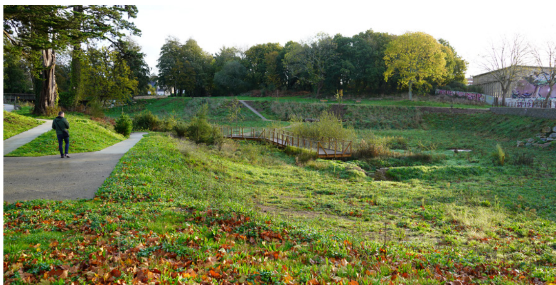
La reconfiguration du parc de Kertatupage a permis de renforcer l'infiltration et le stockage des eaux pluviales à l'échelle du quartier. © Gilles Lecuir
