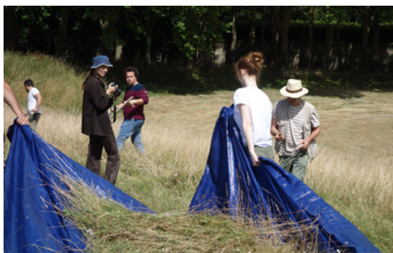
Transfert de foin sur la toiture de l'École des Sciences et de la Biodiversité afin d'enrichir la diversité des espèces prairiales et de favoriser l'implantation d'espèces locales. © Aurélien Huguet
