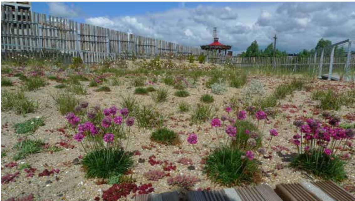
À Nantes, la toiture végétalisée de l'école Aimée Césaire conçue par l'agence de paysage Phytolab est inspirée des milieux dunaires et littoraux. © Phytolab
