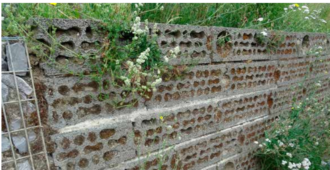
À Lille, des cavités conservées pour les martinets sur la contre-garde de la Citadelle (haut) et une expérimentation à partir de parpaings remplis de terre pour les plantes sauvages (bas). © Gilles Lecuir, Florent Fournier
