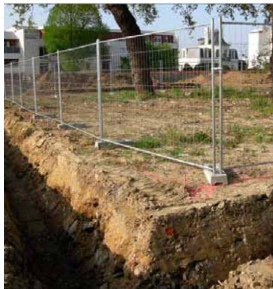
Mise en place de barrières de protection autour des arbres, selon un périmètre élargit permettant de préserver le réseau racinaire. © Gilles Lecuir
