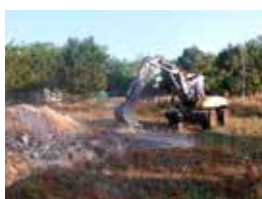
Le diagnostic pédologique est essentiel pour connaître la qualité des sols avant l'aménagement - Réalisation des fosses et description des profils de sol aux Mureaux dans le cadre du projet de recherche Destisol. © ADEME, Marc Barra
