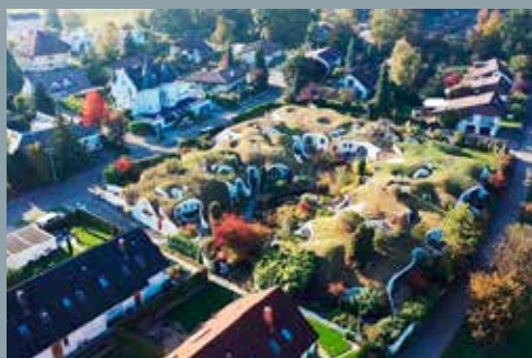
Les Earth Houses de l'architecte suisse Peter Vetsch sont construites dans le sol plutôt que sur le sol. © Google Earth
