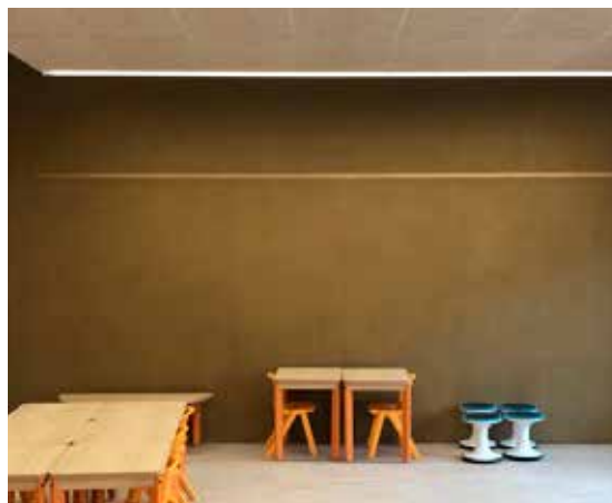
Cloison enduite en terre crue issue de déblais de chantiers d'Île-de-France (murs et doublages en briques de Terre crue extrudée), groupe scolaire Thomas Pesquet à Villepreux. © Paul-Emmanuel Loiret
