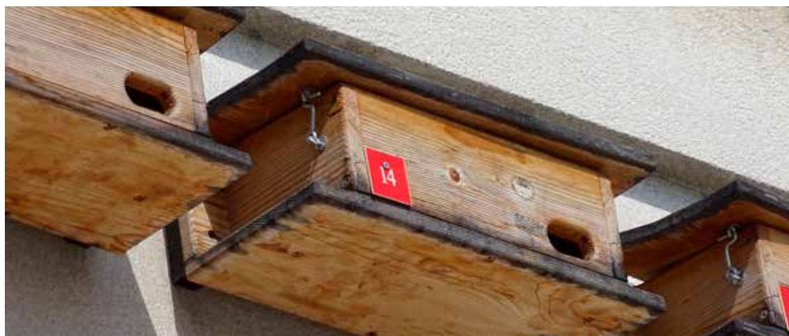
Nichoir à Martinets installés sur une façade à Gennevilliers. © Gilles Carcassès
