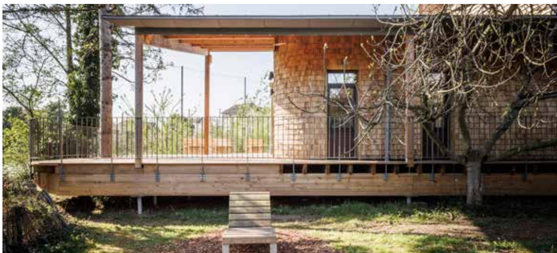
Maison de la réserve écologique à Épinay-sur-Seine, un bâtiment soutenu par 109 pieux vissés. © 11 h45-LAO
