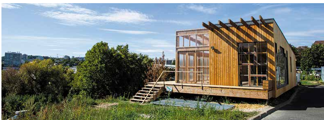
Le bâtiment de bois de l'Agrocité de Bagneux est construit sur des pieux vissés. © CD92, Julia Brechler
