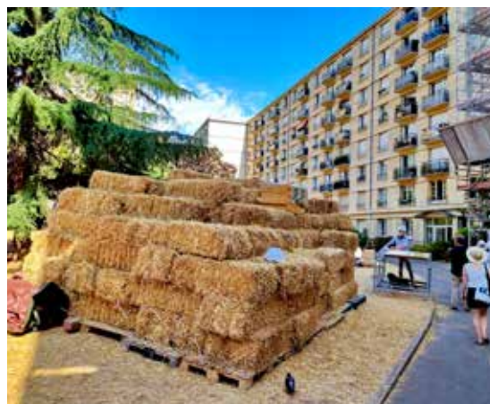
Paris Habitat, un bailleur social de la Ville de Paris, isole par l'extérieur le pignon d'un immeuble existant rue de la Convention, à l'aide de bottes de paille sous enduit. © Paris Habitat ►
