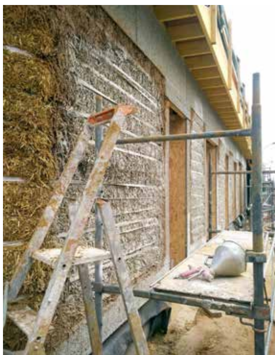
Bottes de paille porteuse pour la construction de l'école des Boutours à Rosny-sous-Bois (93). © Ville de Rosny-sous-Bois
