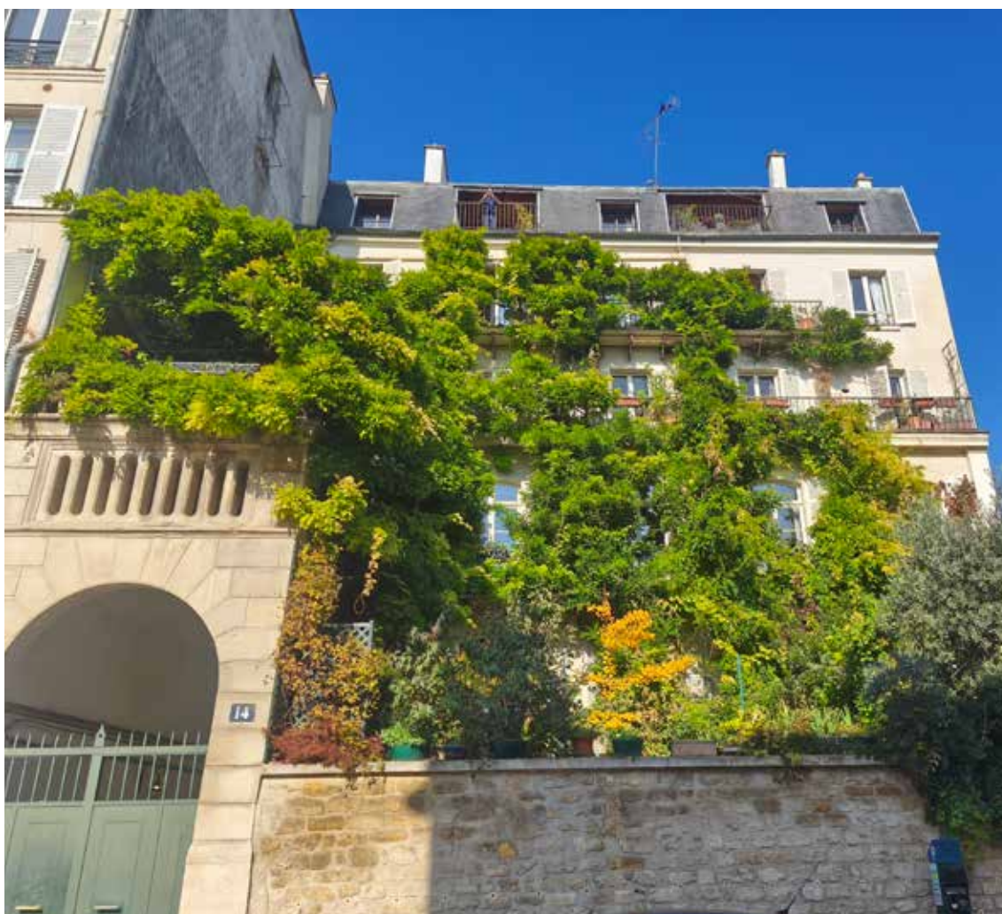
En zone dense, la végétalisation des façades et des toitures fait partie des solutions pour attirer la biodiversité.
