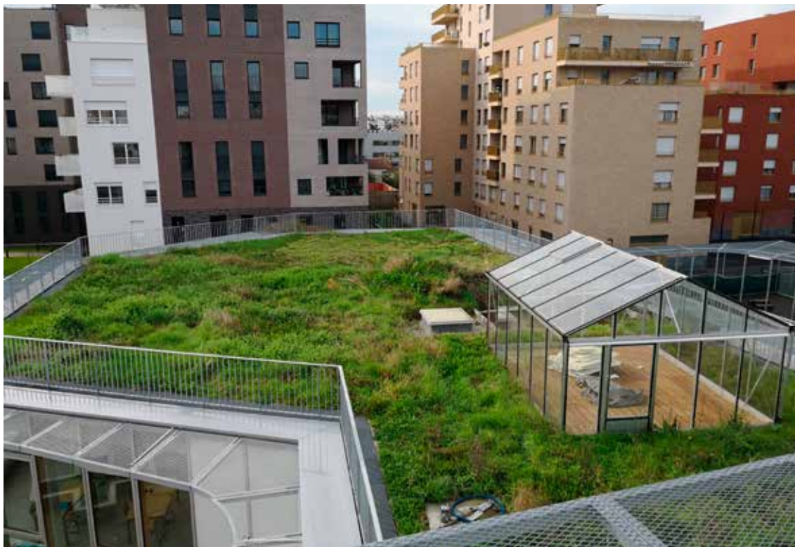
Une toiture végétalisée semi-extensive sur le toit de l'école Rosalind Franklin, réalisée par Chartier-Dalix à Ivry-sur-Seine. © Marc Barra
