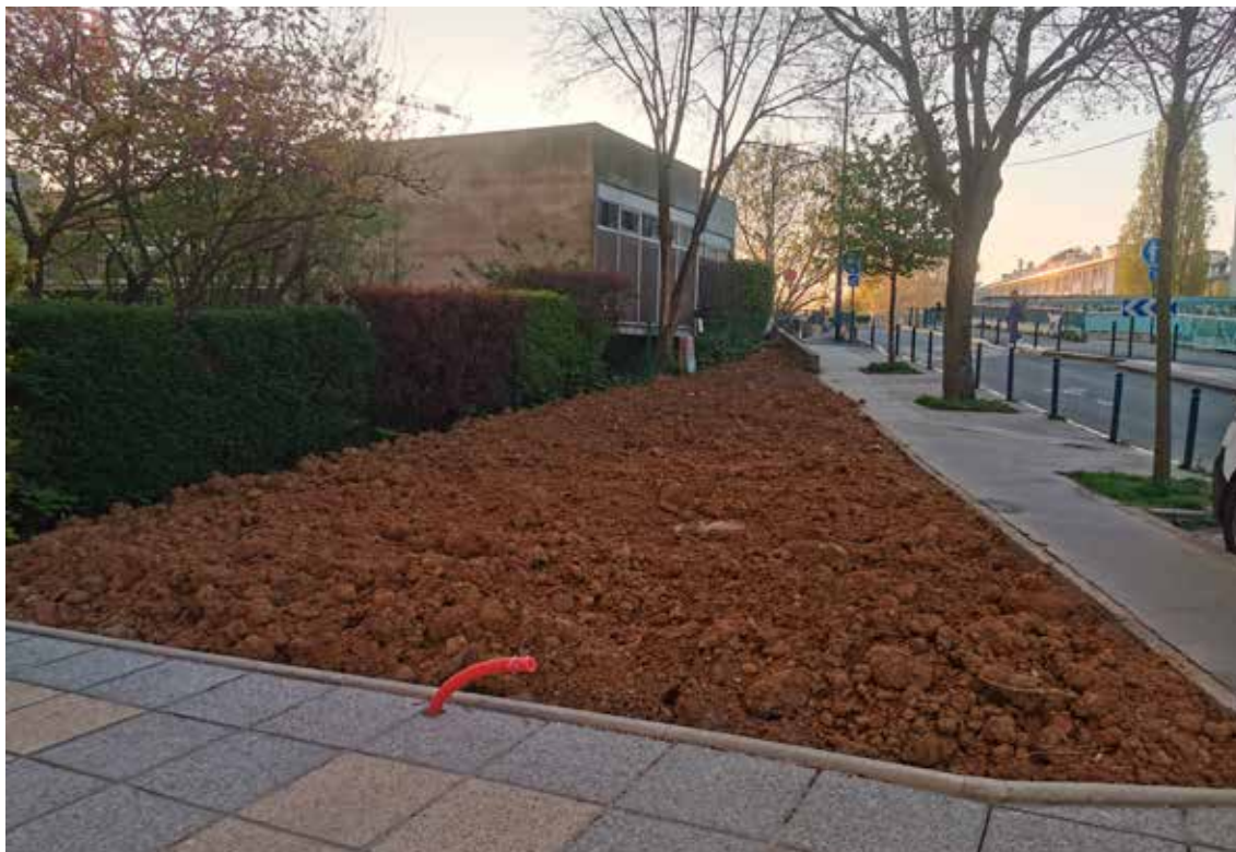
La terre dite « végétale », issue de terres agricoles décapées, peut-être remplacée par des substrats de réemploi ou des technosols. © Marc Barra
