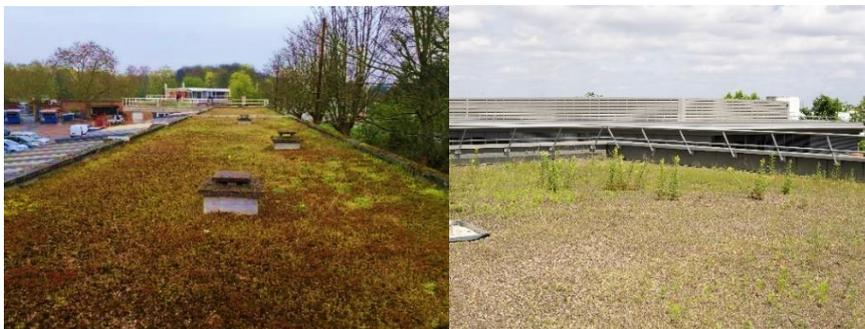
Figure 31 : Toitures spontanées. En haut : toiture sur gravillon dans le parc Georges Valbon, En bas Wild Roof sur substrat à base de pouzzolane (GT MBA, Nanterre) © Marc Barra et Audrey Muratet
