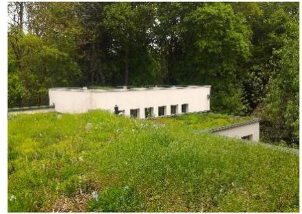
Figure 18 : Toiture de GOOPL dans le Bois de Boulogne, entouré par les feuillus. La chute des feuilles enrichie la toiture en MO fraîche qui se traduit par un rapport C/N plus faible
