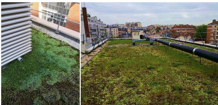
Figure 30: A gauche : Toiture à orpins (AMROU), la présence d'une gouttière crée un micro milieu (ombre et Humidité) qui favorise le développement des plantes. A droite : Toiture à orpins (SIBUET) même constat, l'ombre des tuyaux favorise le développement d'herbacées
