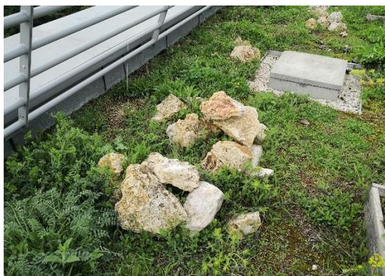
Figure 33 : Création de micro milieux avec des pierres afin de favoriser l'installation de biodiversité (toiture de GTMBA)
