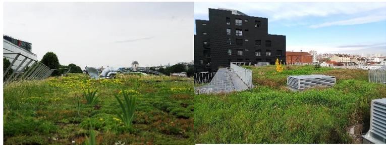
Figure 26 : A gauche une toiture d'une épaisseur de 11 cm retenant 86 000 L d'eau pour 1640 m<sup>2</sup> (CIMOD), A Droite une toiture de 29 cm d'épaisseur retenant 92 000 L d'eau pour 702 m<sup>2</sup> (FRANK)
