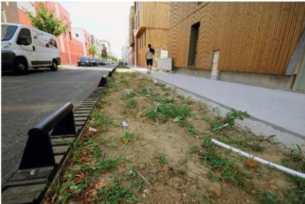
▲ Photo 2. Noue destinée à l'infiltration des eaux pluviales, tassée par les engins de chantiers à Nanterre (92) (source : Marc Barra).
