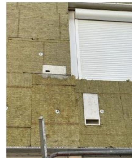
Réserve dans l'isolant avec coupure isolante pour intégration gîte à chiroptères site pilote d'Orly © Elsa Caudron
