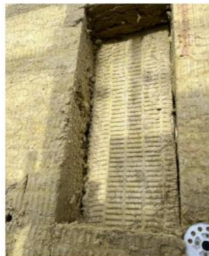
Réserve dans l'isolant avec coupure isolante pour intégration gîte à chiroptères site pilote d'Orly © Elsa Caudron
