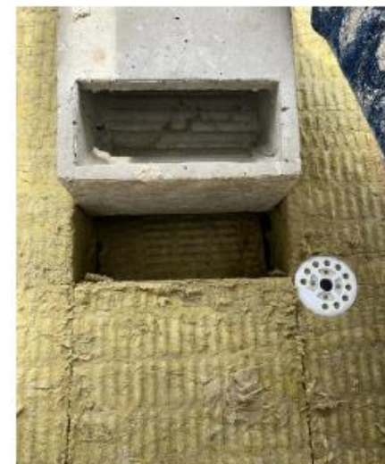
Réserve dans l'isolant avec coupure isolante pour intégration gîte à chiroptères site pilote d'Orly © Elsa Caudron
