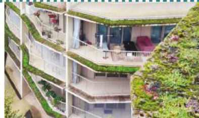
Bordure de balcon Logements Herold, Jakob MacFarlane
