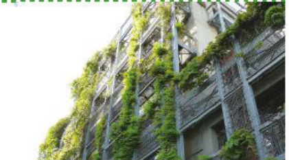
Grimpantes en pleine terre, se développant sur support en façade
