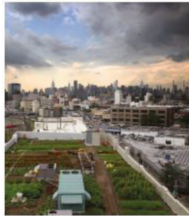
FERME URBAINE SUR LE TOIT DU PARKING SILO
