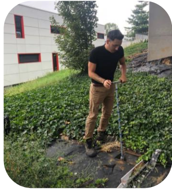
Sondages à la tarière
