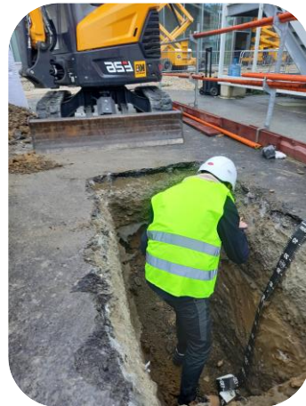
Ouverture d'une fosse pédologique à la mini-pelle
