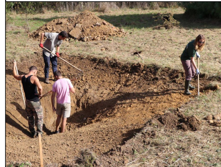
Etape 2 - Création du fond de forme et décapage des margelles
