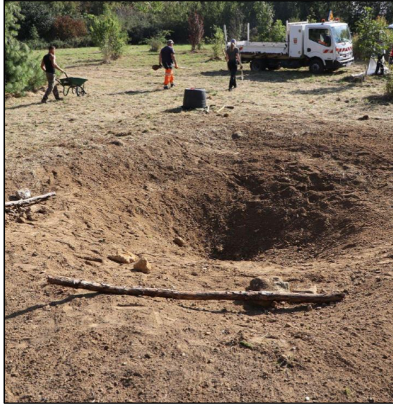
Etape 8 - Création du fond de forme et décapage des margelles
