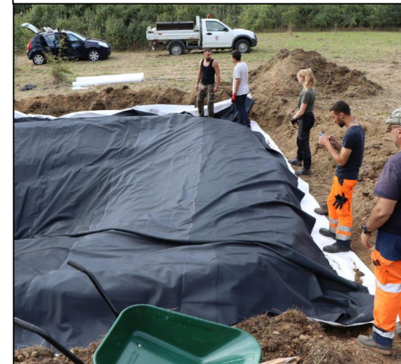
Etape 6 – Pose de la bâche étanche (100 m 2 ) et pose d'un géotextile
