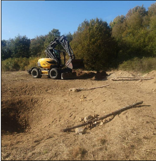
Etape 7 – Modelage des talus et des abords
