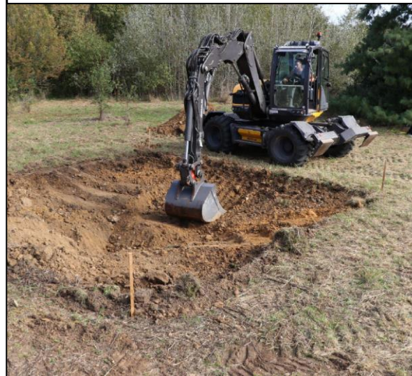
Etape 1 - Creusement de la forme générale de la mare
