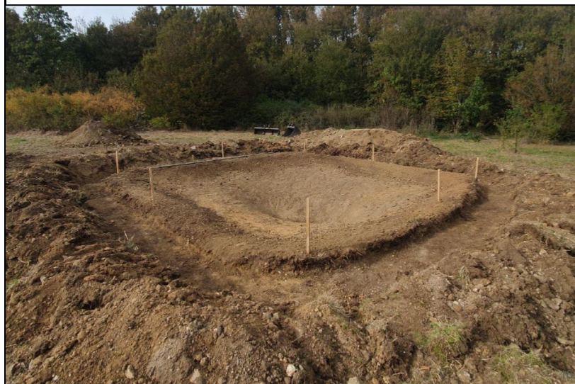
Etape 3 – Creusement de tranchées sur le pourtour et mesure des niveaux
