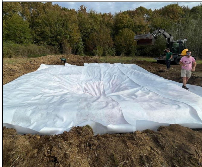
Etape 5 – Pose de 2 couches de protection
