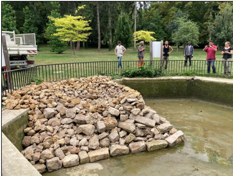
Travaux de valorisation du bassin d'agrément (cimenté) du parc Gravelin avec un empierrement pour faciliter les accès des amphibiens et créer un habitat plus qualitatif.
