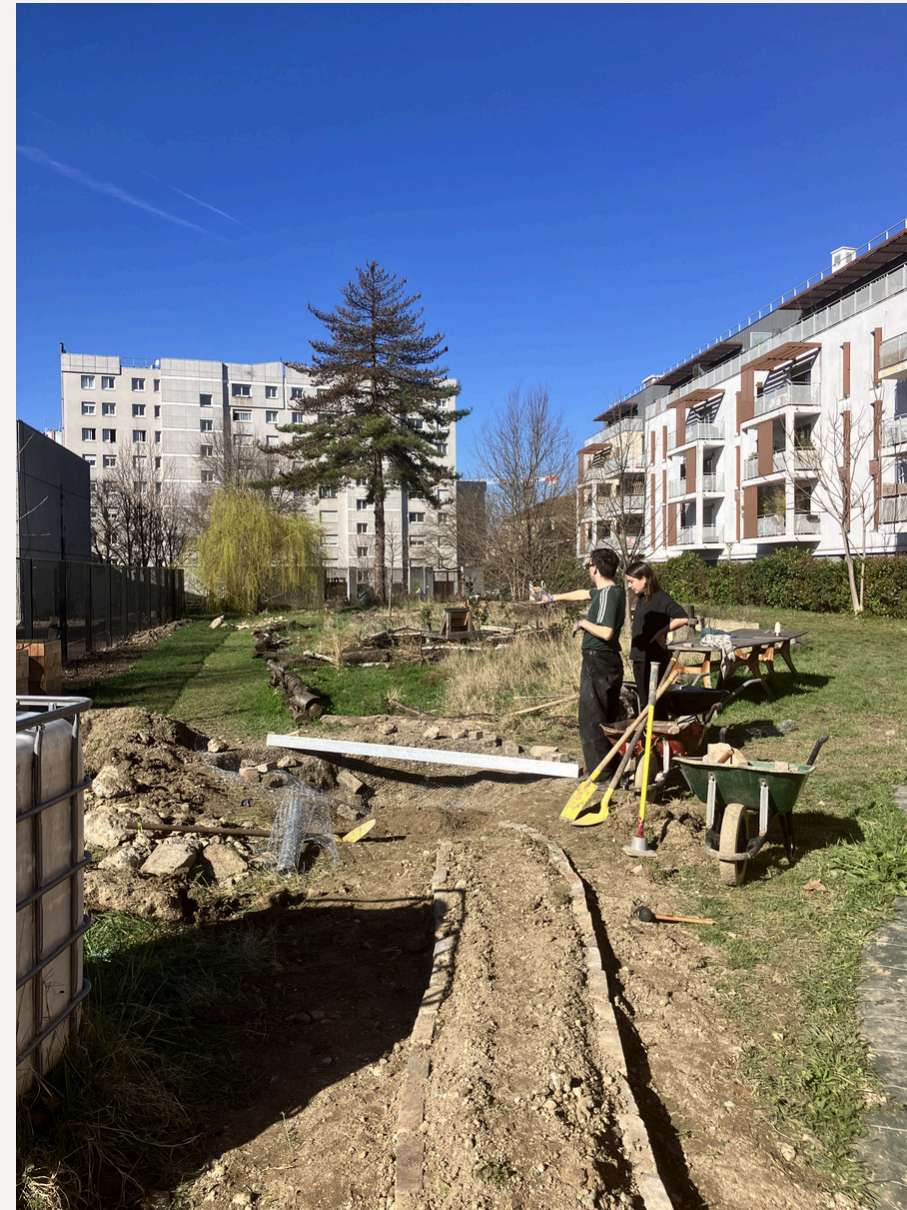
Création de la butte de récupération d'eau et de la pente qui permet d'alimenter la mare.
