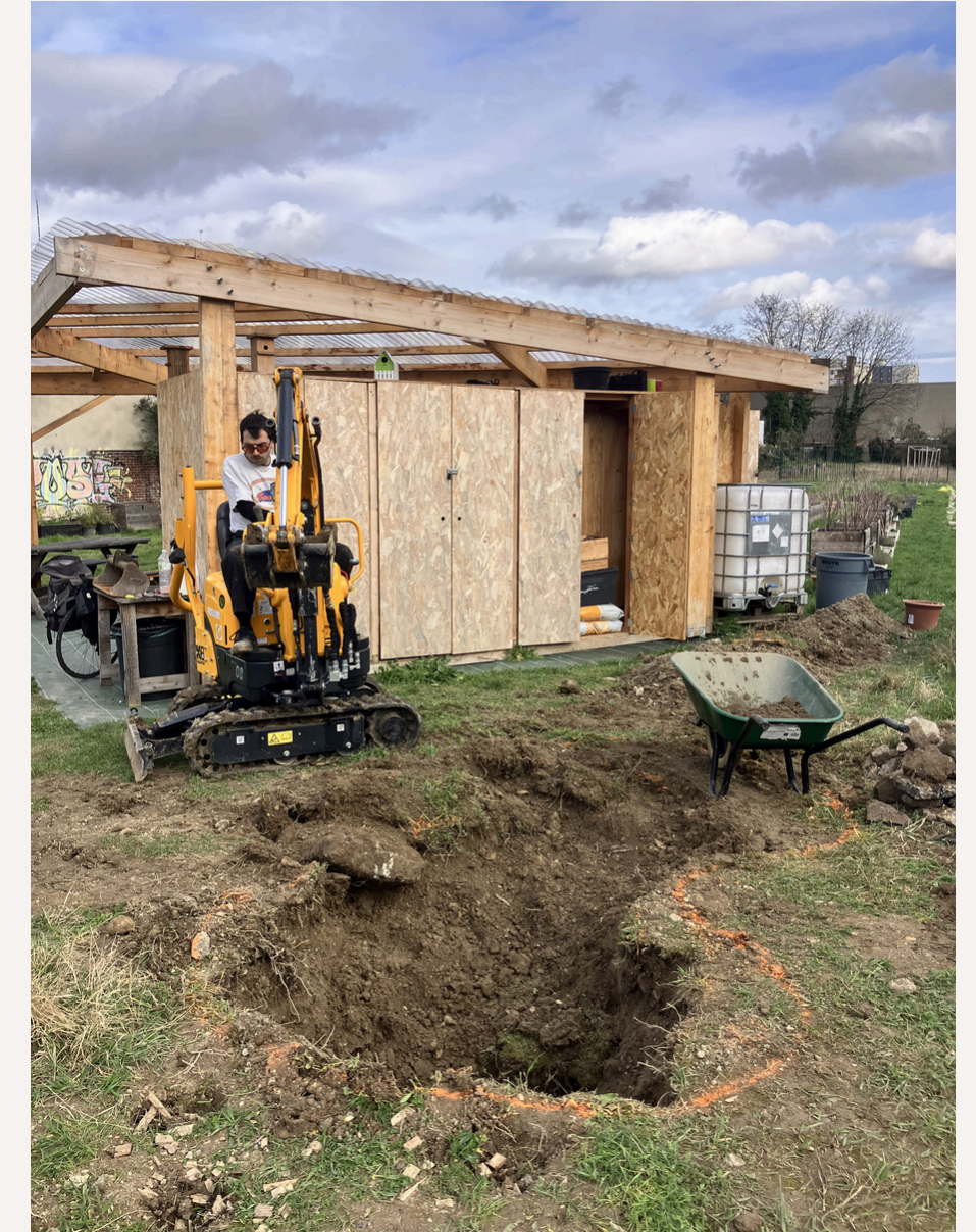
Utilisation de la terre creusée ainsi que des remblais pour créer la butte de récupération d'eau ainsi que les buttes qui serviront de lieux refuges pour la faune.
