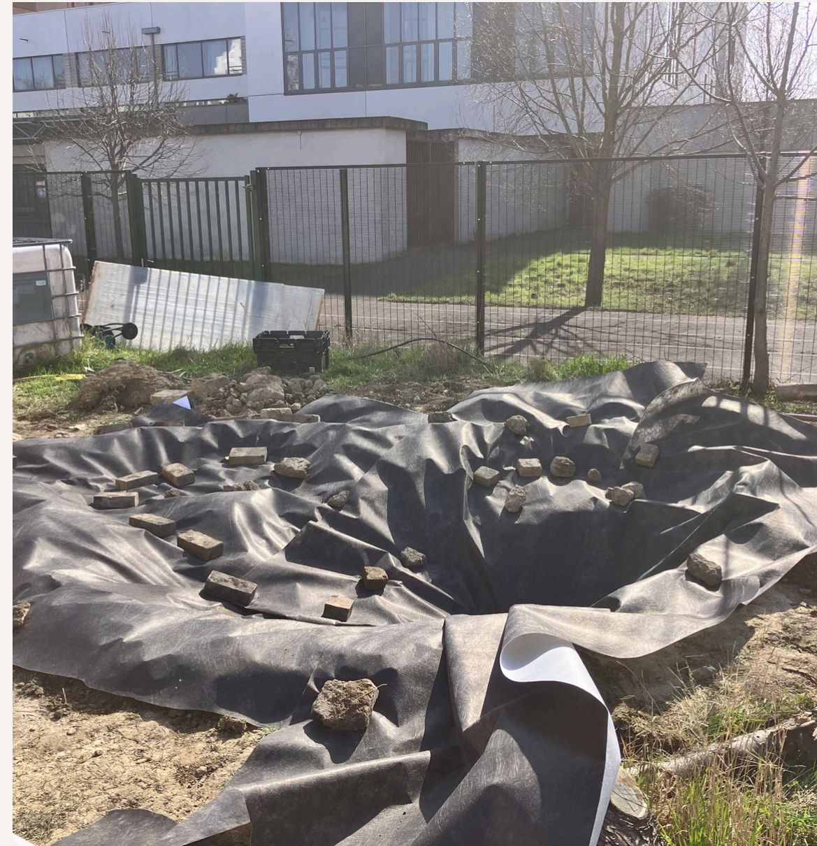
Utilisation de pavés pour marquer la topographie de la mare, ainsi que les pentes et les profondeurs.
