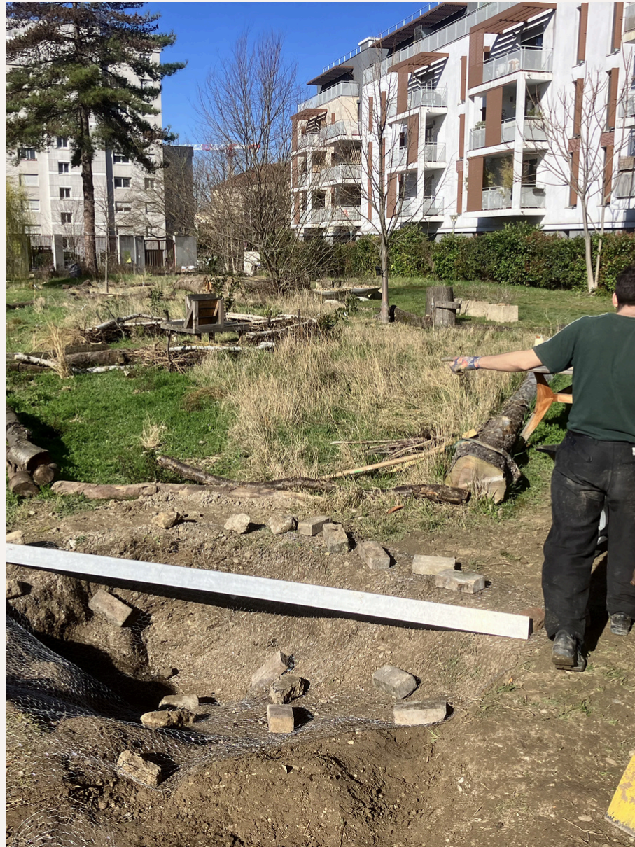
Mise à niveau des berges de la mare, et création de la zone de débordement qui permettra la création de la zone humide inondable
