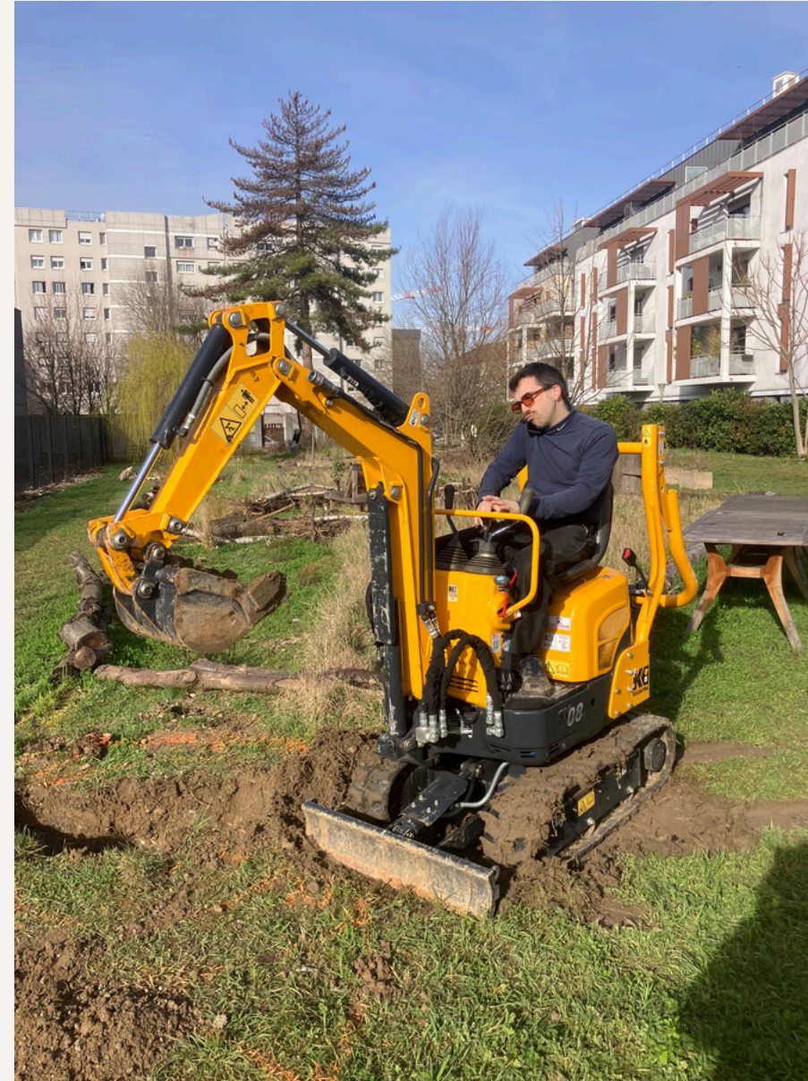
On creuse la mare à la minipelle, en respectant chaque palier. Utilisation de la règle pour suivre les profondeurs creusées.
