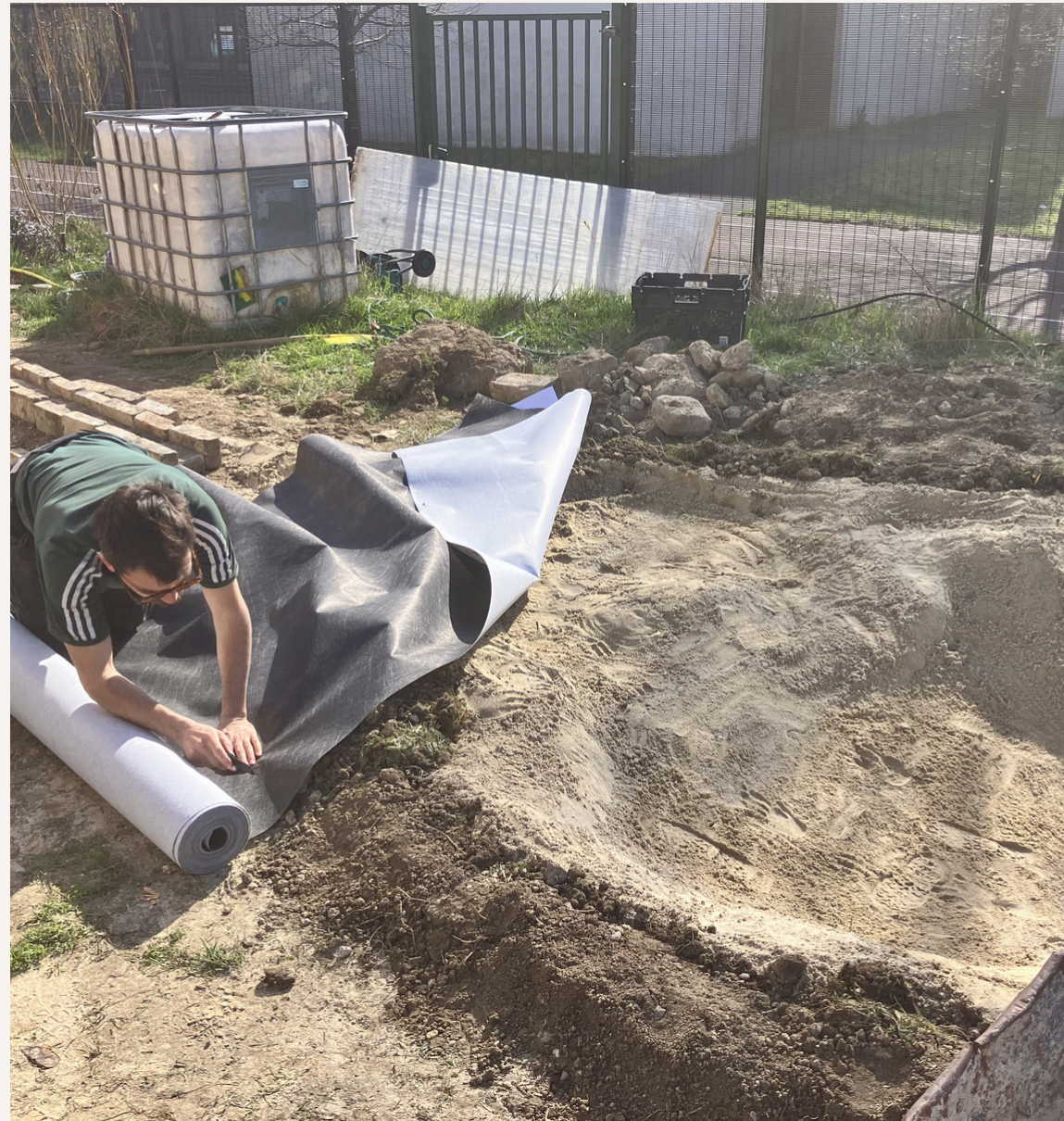
Installation du géotextile avec agrafes de jardin
