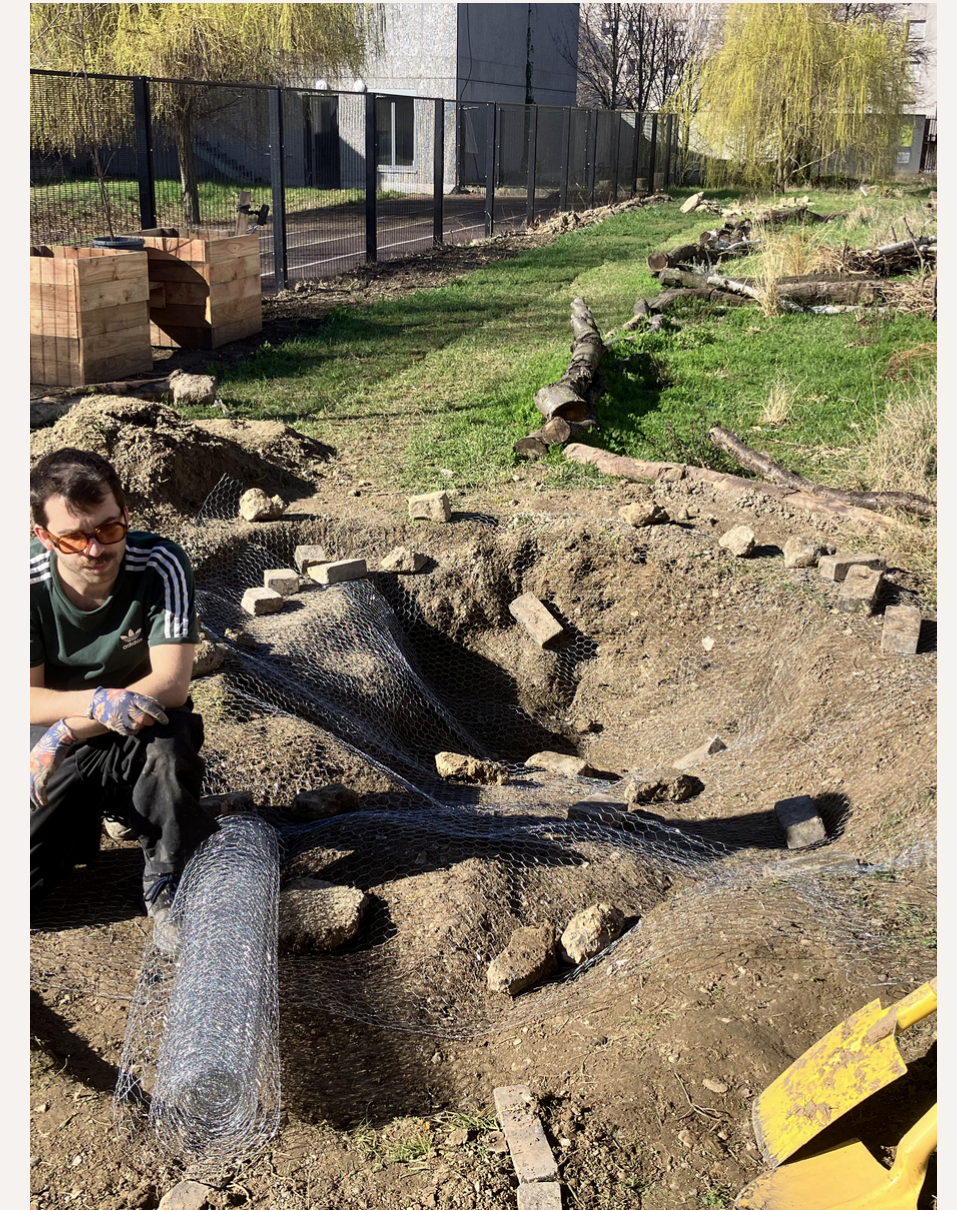
Enlever les cailloux, les remblais et tout matériel pointu ou tranchant, et installer le grillage avec des agrafes de jardin.
