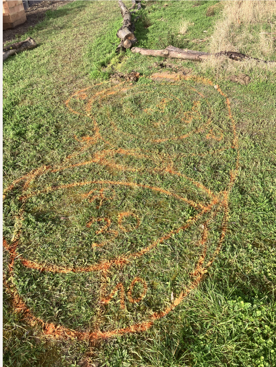
Délimitation de la zone creusée de la mare, ainsi que des différents paliers (plagette, zone submergée, zone profonde, etc.)
