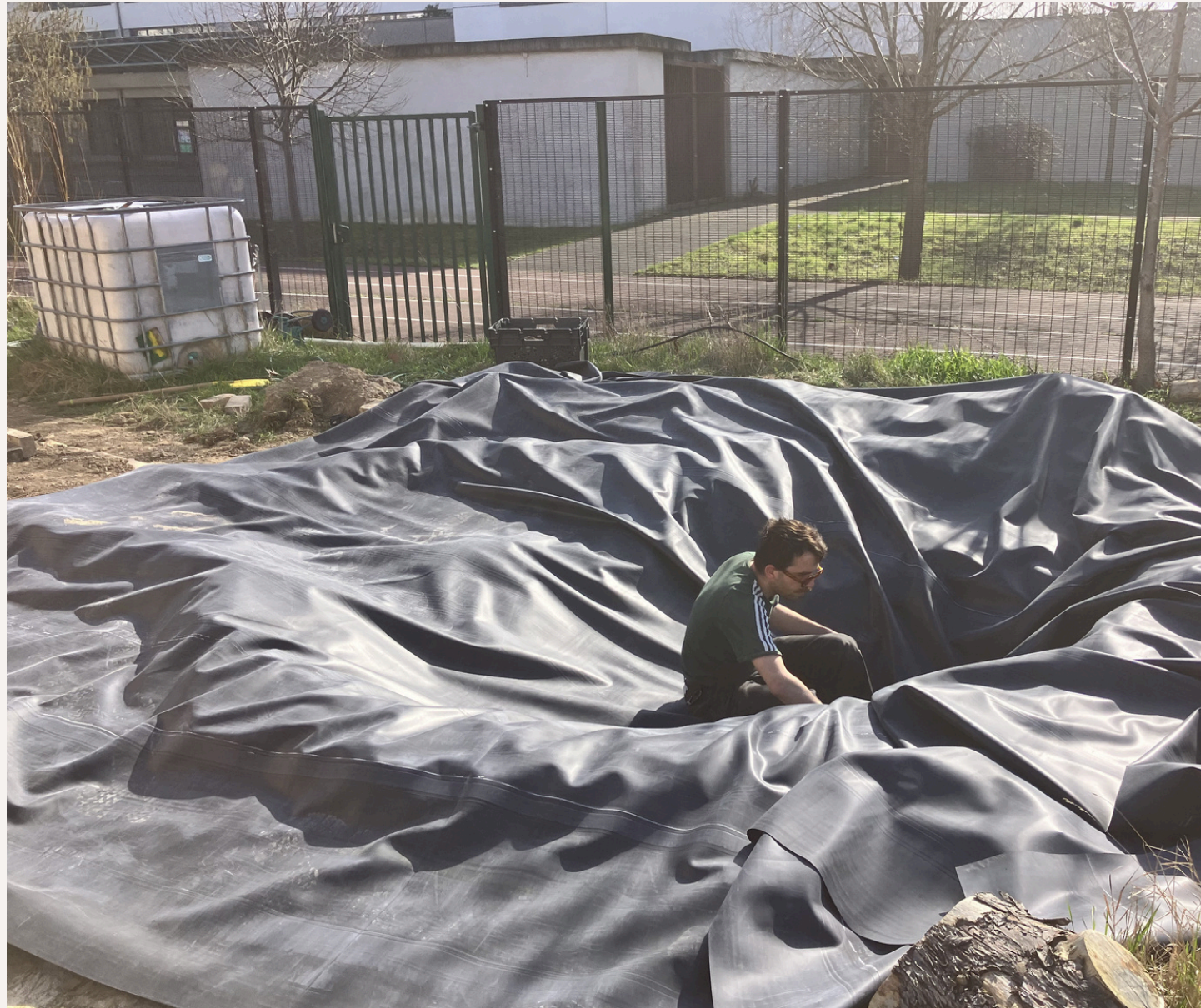
Installation d'une bâche unique en EPDM.
