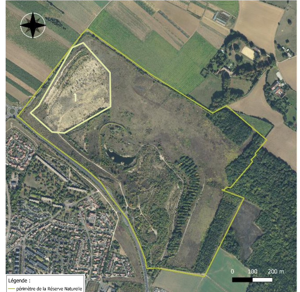
1 LE CARREAU ET LE GRAND FRONT DE TAILLE
