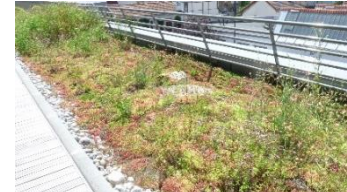
Toitures végétalisées (>8cm)
