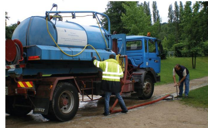
Pompage, stade de Porchefontaine
