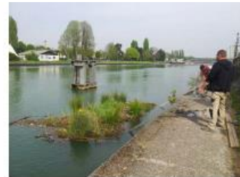
Intervention du partenaire Marcanterra pour le remplacement du bracon (Photo S.PASQUET – Avril 2015)
