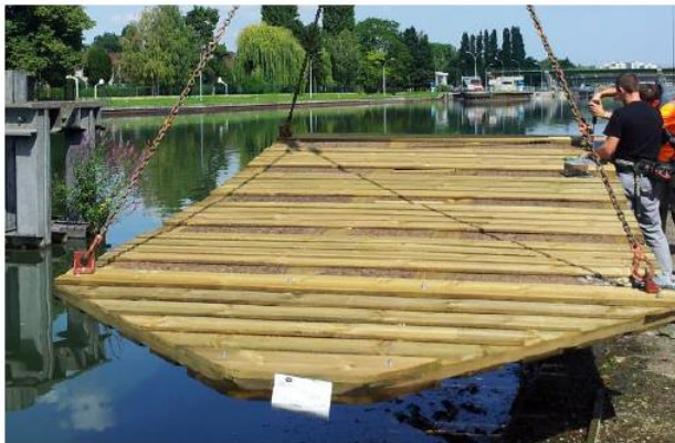
Mise en place de la structure « sandwich » monobloc bois/liège
