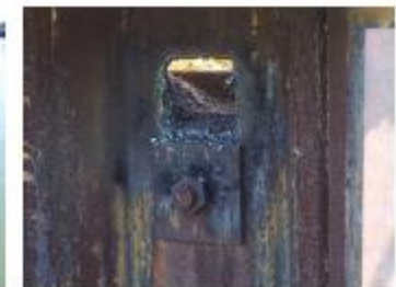
Perçement de la palplanche pour la conception des nichoirs à martin pêcheurs
