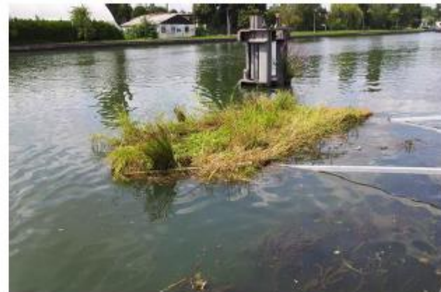
Vue avant - Aspect de l'îlot végétal après la mise en place des nappes précultivées. (Photo S.PASQUET – Août 2014)
