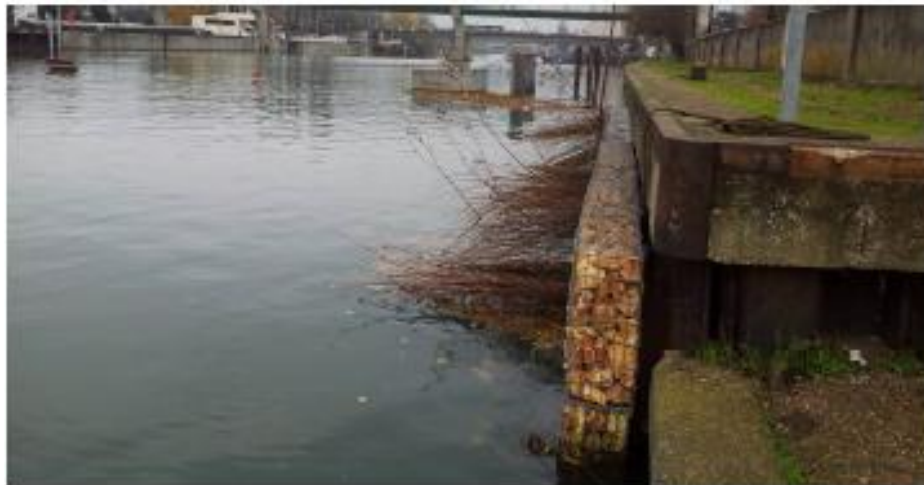
Aspect de la paroi végétale après travaux
