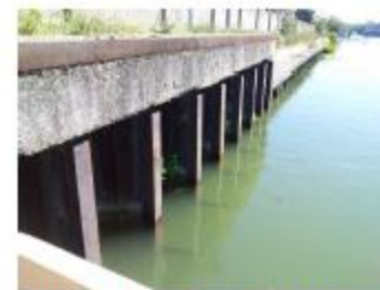
Rideau de palplanches avec les HEA 140 soudés devant recevoir les gabions (en partie immergée on distingue les équerres d'appuis)
