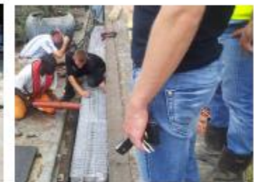
Mise en place des tubes pour les nichoirs
