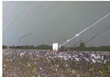
Rupture d'un des bracon (Photo S.PASQUET – Février 2015)
