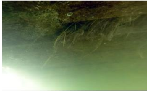
Vue en sous face de l'îlot végétal actuel Très faible développement racinaire subaquatique
