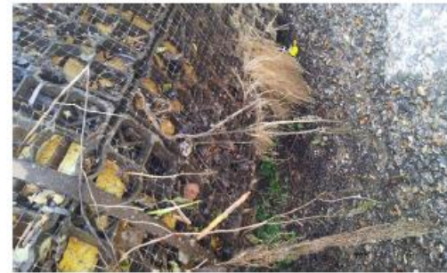
Vue de la sous face du premier îlot végétal le système racinaire se développe en partie subaquatique
