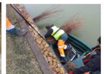
Mise en place de branches de saules
