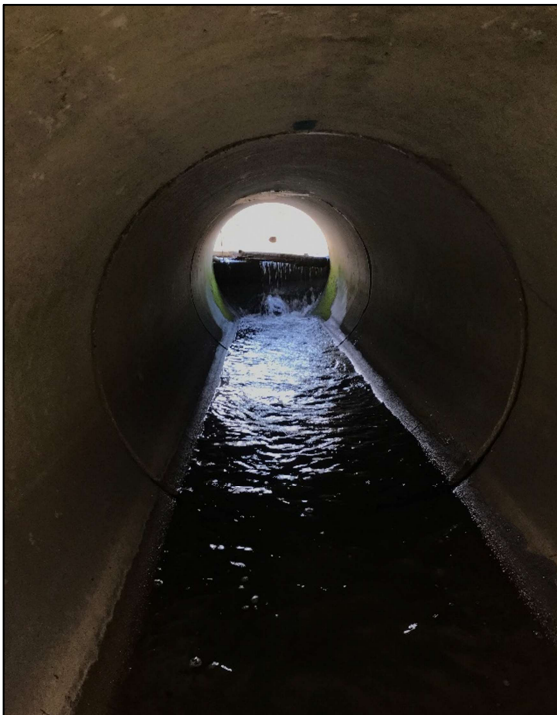
Etat initial de l'ouvrage de régulation du Bassin (vue aval)
