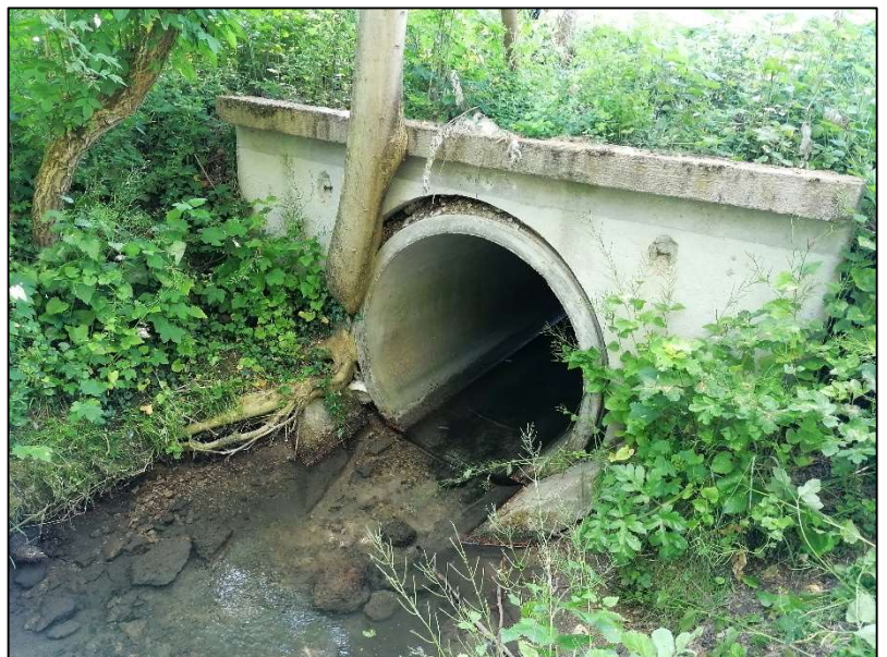
Etat initial de l'ouvrage de régulation du Bassin (vue aval)
