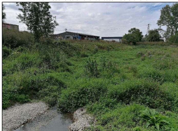
Connexion aval finalisée
