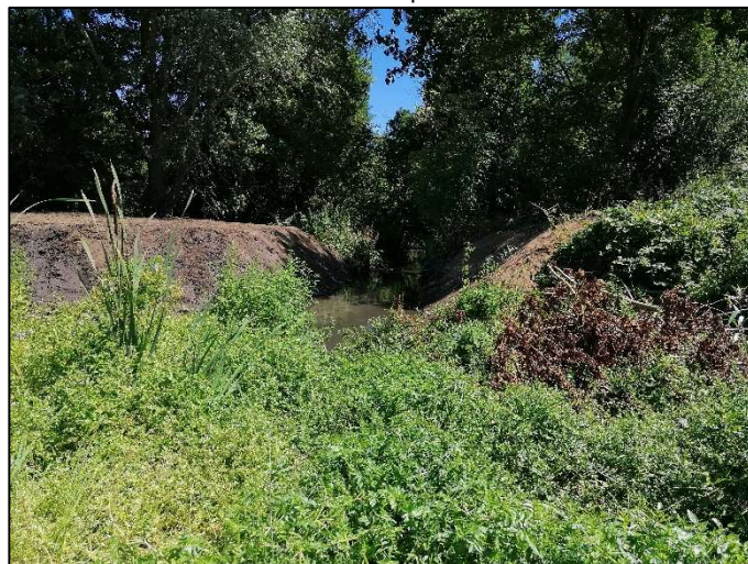
Section réouverte en aval du bassin de Gravelle
