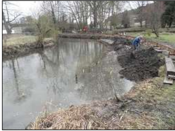
Apport de matériaux via un système de rail
