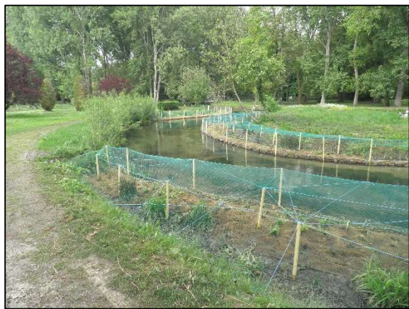
Mise en place d'un grillage de protection pour hélophytes
