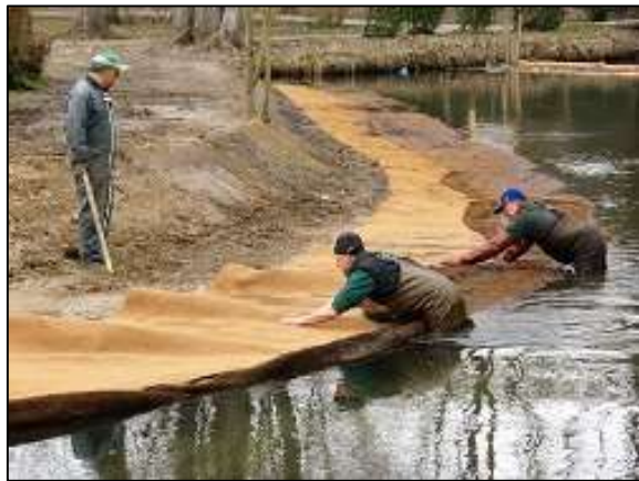
Fermeture du géotextile biodégradable
