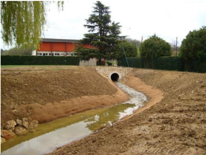
En 2010, les travaux
