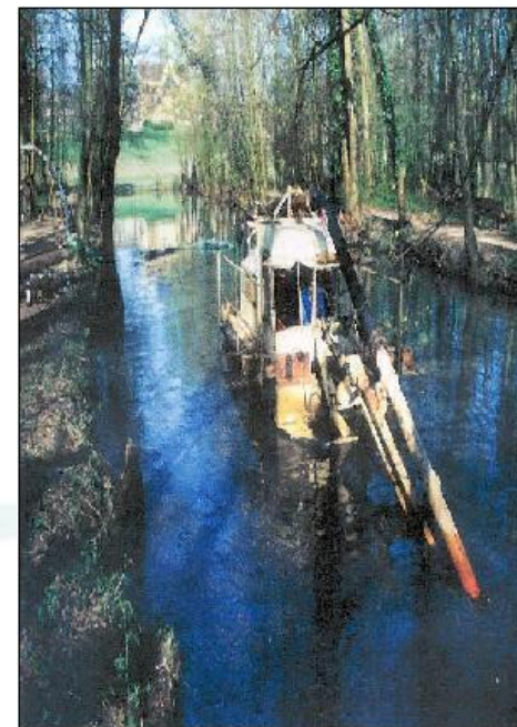
Curage par une suceuse au Bassin de Lormoy à Saint Michel-su Source : photothèque S.I.V.O.A.
