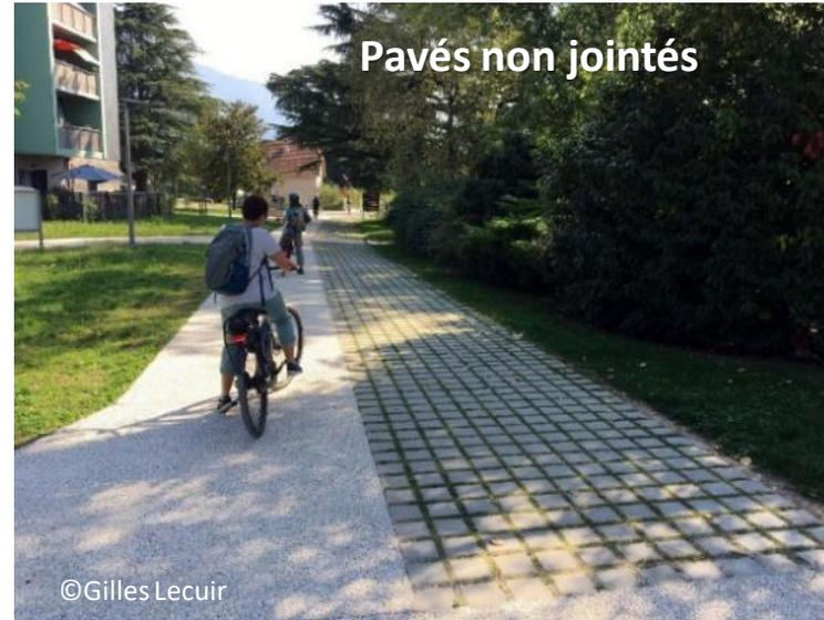
Désimperméabilisation consiste uniquement à redonner une perméabilité à la couche superficielle du sol, souvent grâce au recours à des revêtements poreux et drainants.
