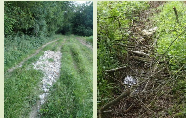
Comblement de deux ornières - courant juillet 2014
