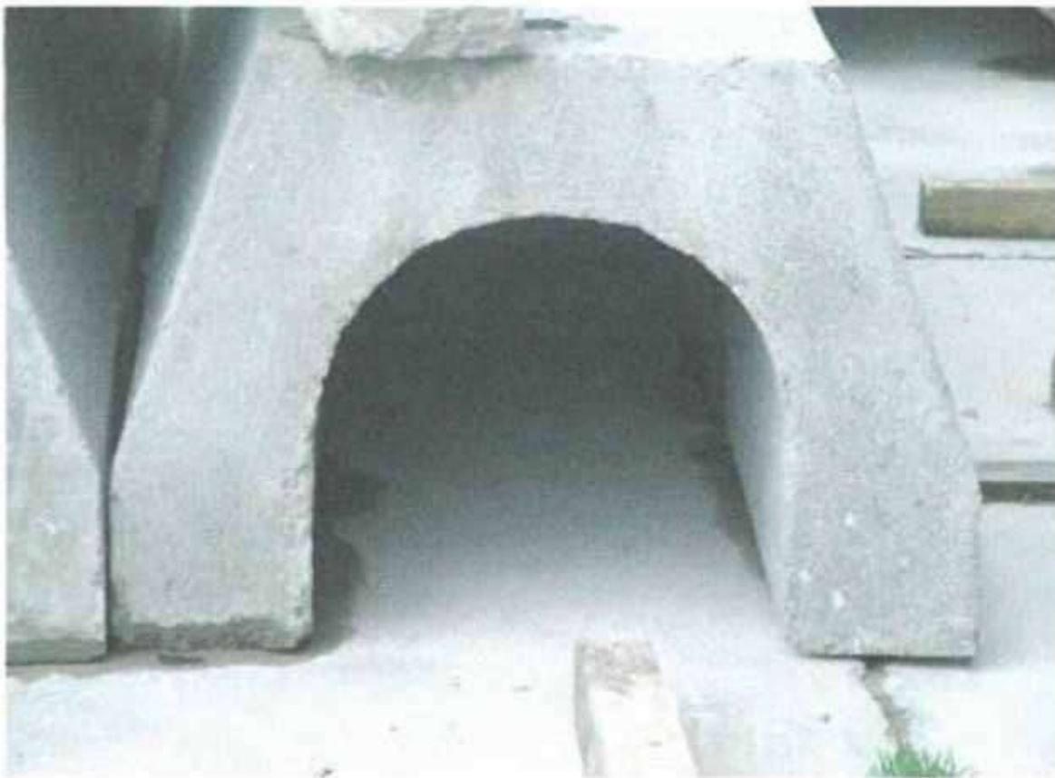
Passage de type IIb avec cadre ouvert en mini-tunnel
