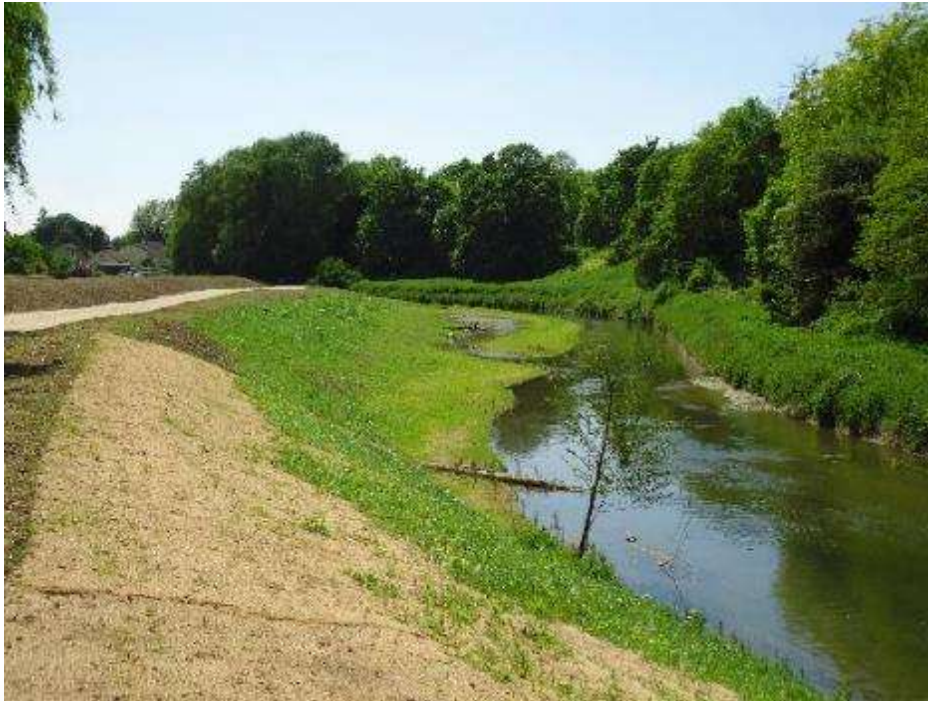
Coteau des Vignes à Athis Mons en 2017 : rétrécissement du lit, décaissement des remblais, création d'un milieu annexe
