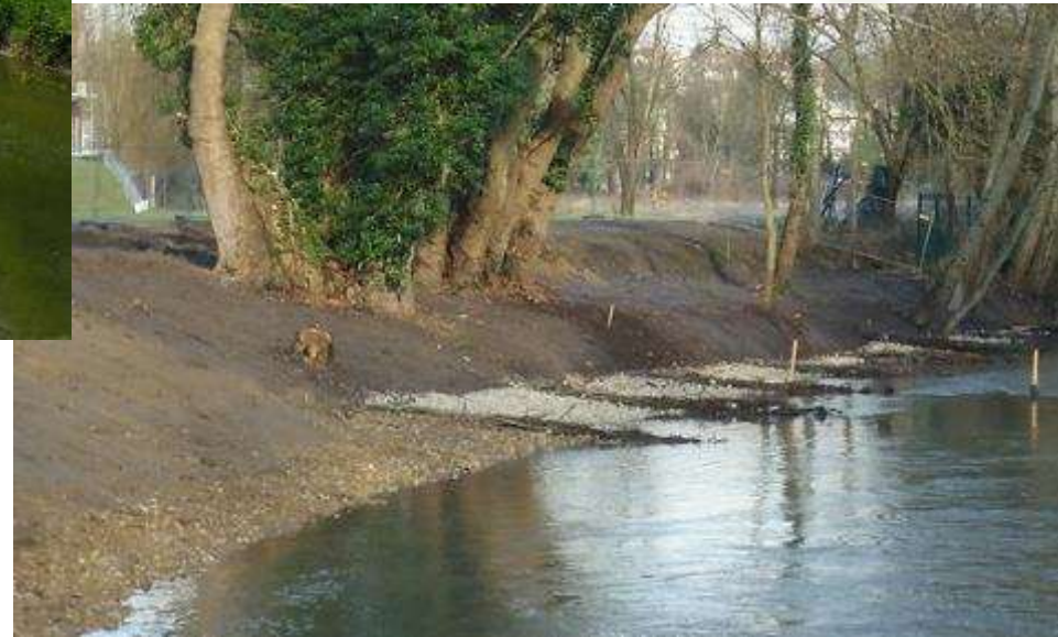
Evasement des berges et rétrécissement du lit de l'Orge à Duparchy à Viry-Châtillon en 2016
