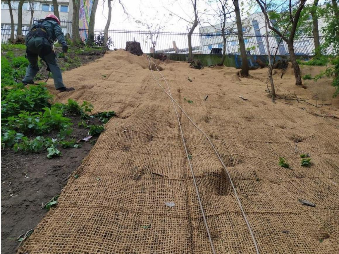
*Recouvrement par géotextile en fibre de coco, talus Périchaux, PC15 à Paris ( 75015, chantier PCEV)*
