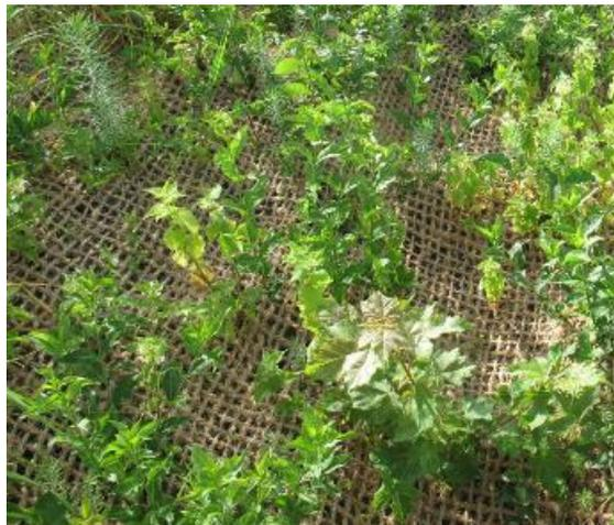
Recouvrement par *géotextile en fibre de coco*
