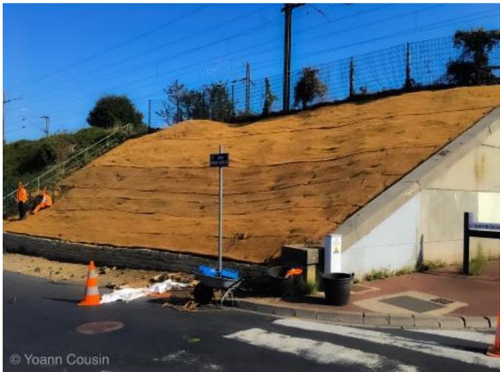
Recouvrement par géotextile en fibre de coco et soutènement du pied de talus par un muret de pierres sèches, semis de prairie.
