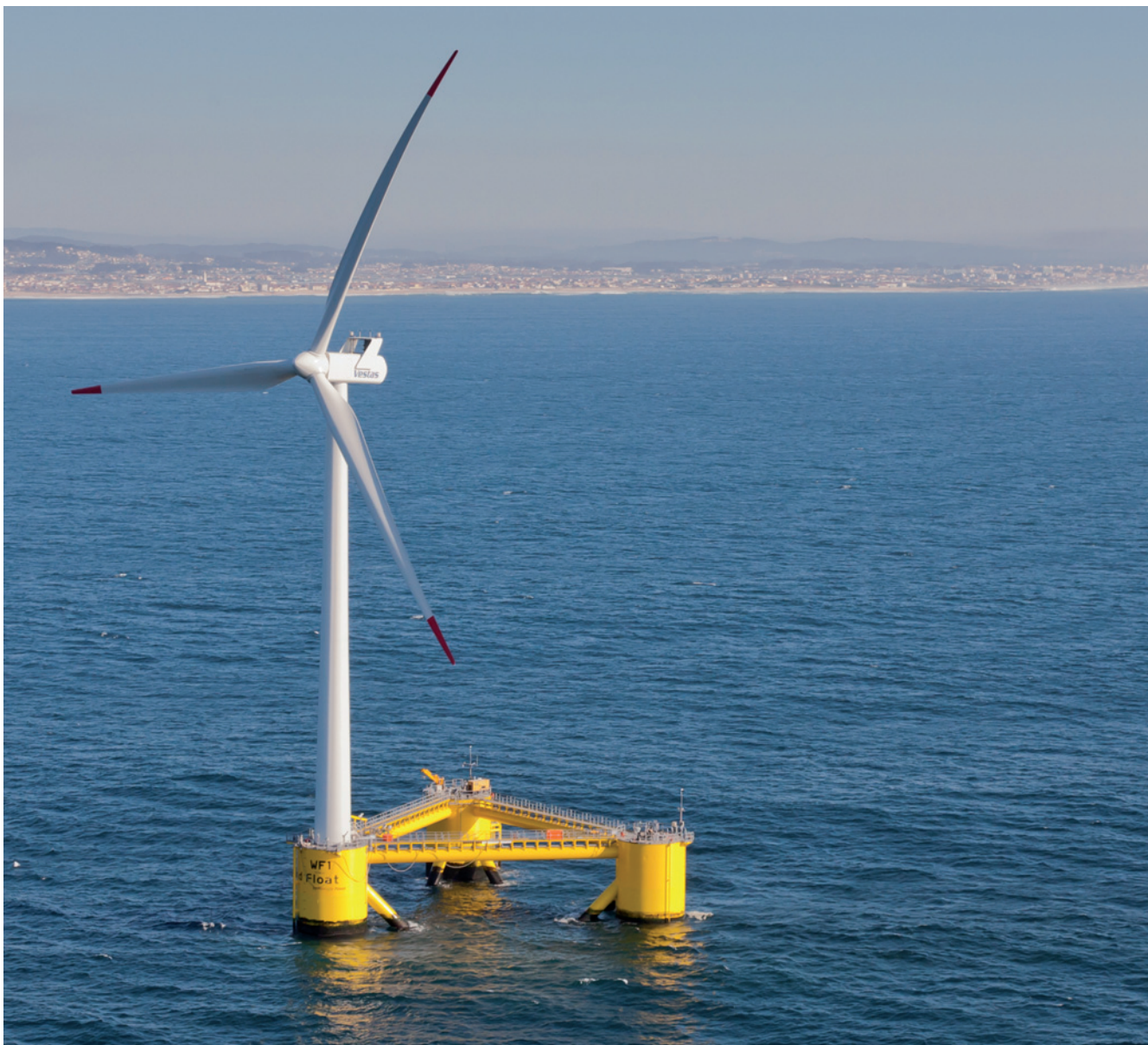
Les impacts des énergies renouvelables marines sur les habitats patrimoniaux : coraux froids, laminaires, bancs de maërl, herbiers de posidonie, etc. peuvent être considérables, et devraient être pris en compte lors des choix d'implantation. Ci-dessus : un prototype d'éolienne flottante au Portugal.
