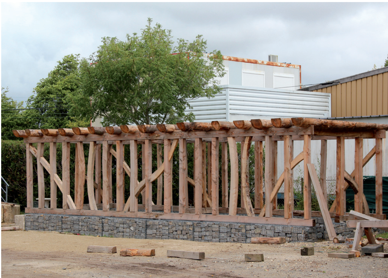
Il faudrait soutenir la première transformation par les scieries locales. Cette transformation tire de 50 % à 60 % du bois sous forme de planches, la part restante pouvant être utilisée sous forme de bois-énergie, de panneaux ou de papier. Ci-dessus : construction d'un abri à vélo en bois local à Lorient.
