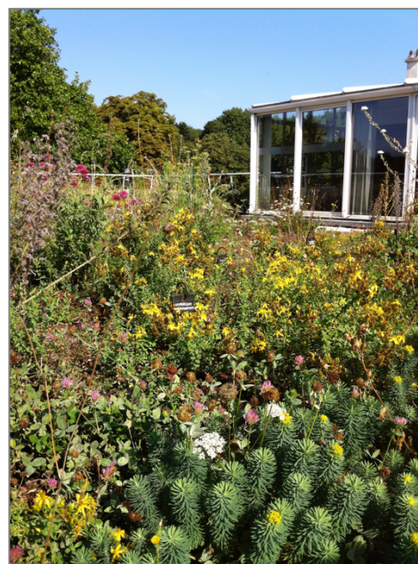
Photo 10 : Toiture végétalisée à la Courneuve (93)
