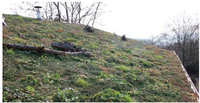
Afin de proposer des niches écologiques multiples, les substrats disposés sur les toits doivent comporter une couche de terre d'une épaisseur minimale de 12 cm et peuvent accueillir des milieux variés : bois morts, arbustes, etc. Il est aussi possible d'implanter des nichoirs à oiseaux et à insectes.
