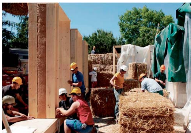
Les murs extérieurs du bâtiment des services des Domaines de Lausanne ont été construits en utilisant une paille produite localement. Le chantier, largement expérimental, a permis de proposer à des entreprises locales de se former à ces nouvelles techniques.
