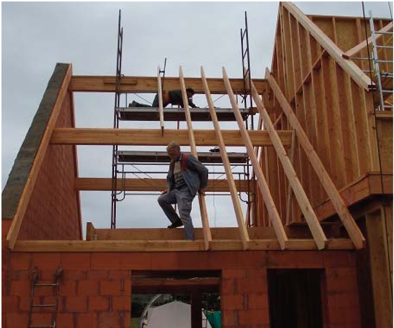
La commune de Flagy (Seine-et-Marne) a accordé un permis de construire et soutient la démarche d'autoconstruction d'un particulier, qui bâtit en utilisant des matériaux d'origine locale et renouvelable, notamment le bois et la paille.
