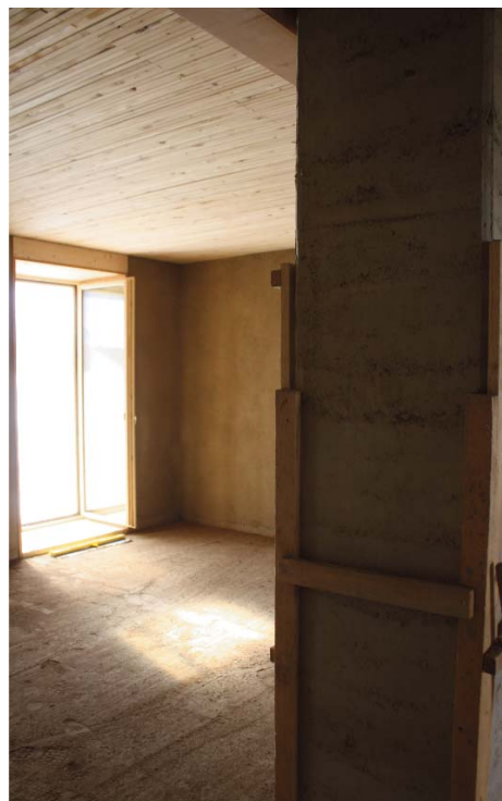
Détail du mur porteur central en pisé.
