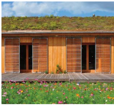
Gymnase de Saint-Céré (Tarn). Ce premier bâtiment construit en paille porteuse en France comporte un toit végétal dont la conception reproduit le plus possible les milieux environnants : ce principe de base a notamment permis de répondre à la demande d'intégration paysagère dans ce site classé par les Architectes et bâtiments de France.
