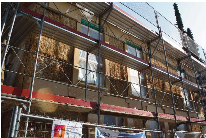
Les murs extérieurs sont en bottes de paille porteuses.
