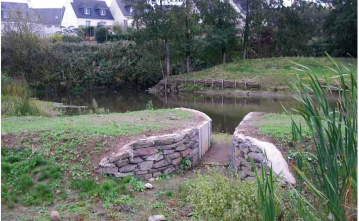
Détail de l'ouvrage de régulation des eaux.
