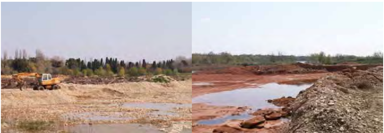
Extension d'un étang sur le site Natura 2000
