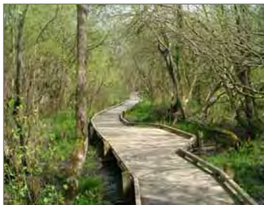
Le platelage dans le marais, accessible aux handicapés, avec le fil d'Ariane
