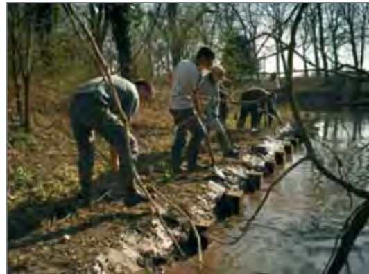
Un chantier de l'association « Les Blongios » consacré à l'étrépage du sol en bordure des fossés, destiné à activer la banque de graines
