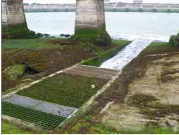
Sortie de la conduite côté Adour
