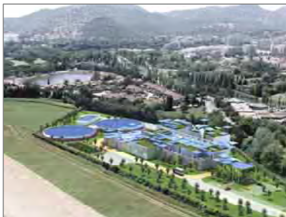
Station d'épuration « Aquaviva » en cours de réalisation, carboneutre et dont l'eau épurée sera utilisée pour le nettoyage des rues et l'arrosage des espaces verts et golfs.
