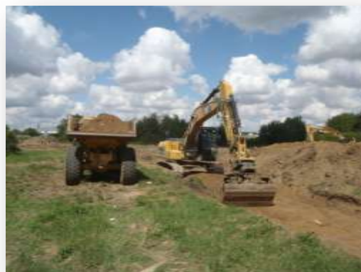
Travaux de terrassement (décapage, déblai, remblai, ...)
