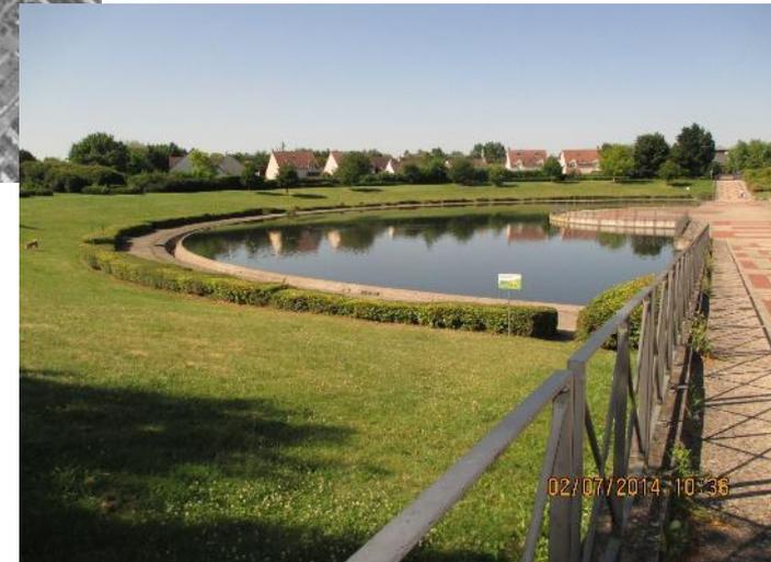
→ Aménagement typique des années 80 où les bassins de rétention des eaux pluviales, étaient pensés uniquement pour pallier le risque d'inondation et non pour être également vecteurs d'usages, d'appropriations et d'appui/développement de la trame verte et bleue.
