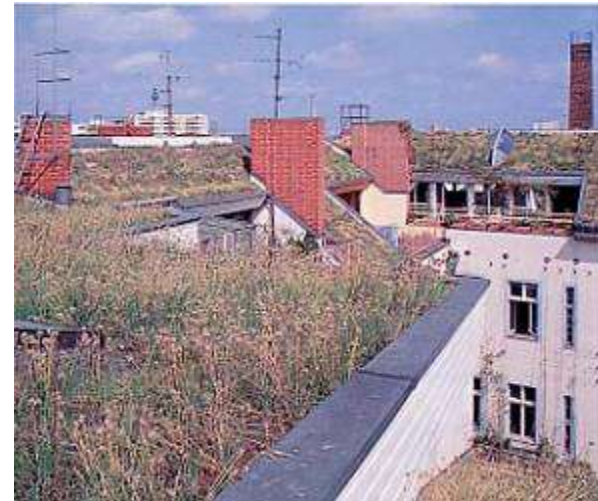
Toits végétalisés extensifs sur un immeuble à Kreuzberg
