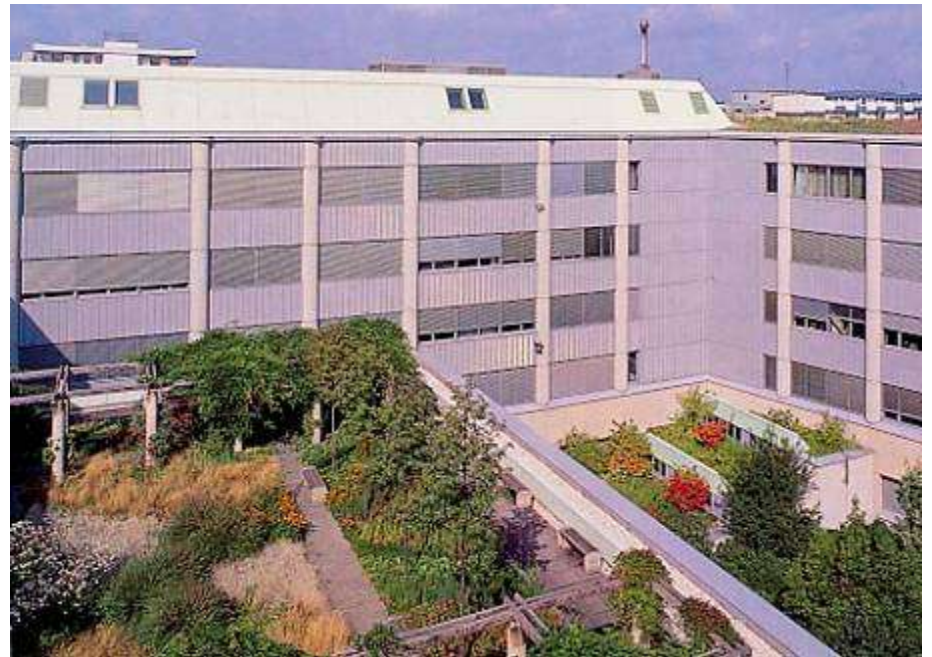
Les terrasses végétalisées – administration de la Caisse d'Epargne à Wilmersdorf
